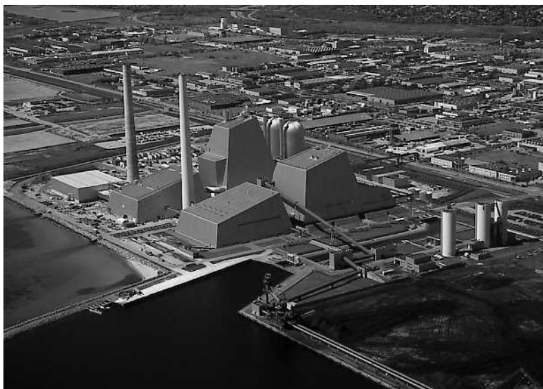
Rys. 12.1. Elektrociepłownia Avedøreværk. Drugi blok (po lewej, z tyłu) spala rocznie 300,000 ton pelet drzewnych
