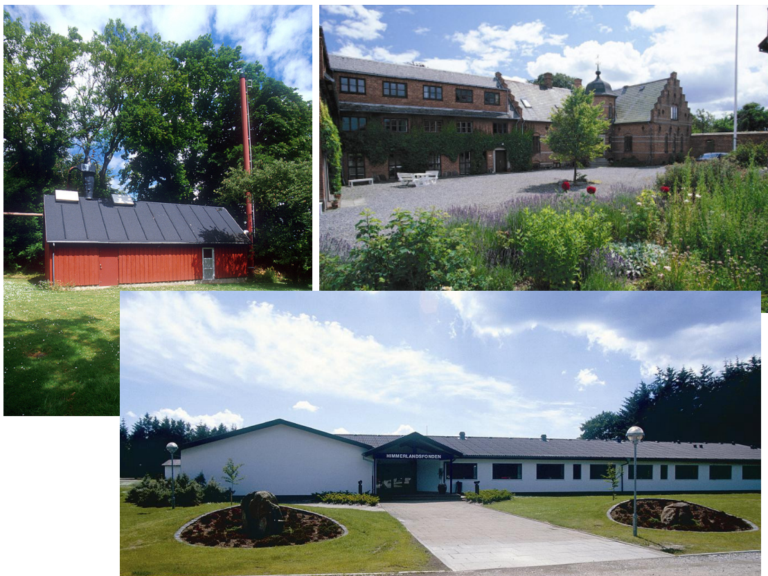
Rys. 10.1. Przykłady obiektów objętych dużymi instalacjami grzewczymi
