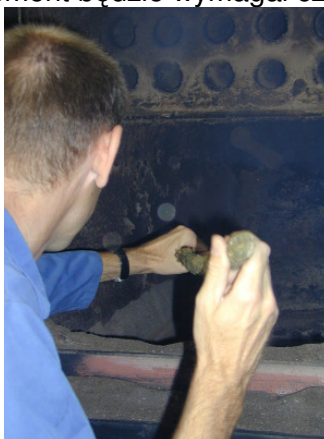
Rys. 10.2. Czyszczenie kotła
