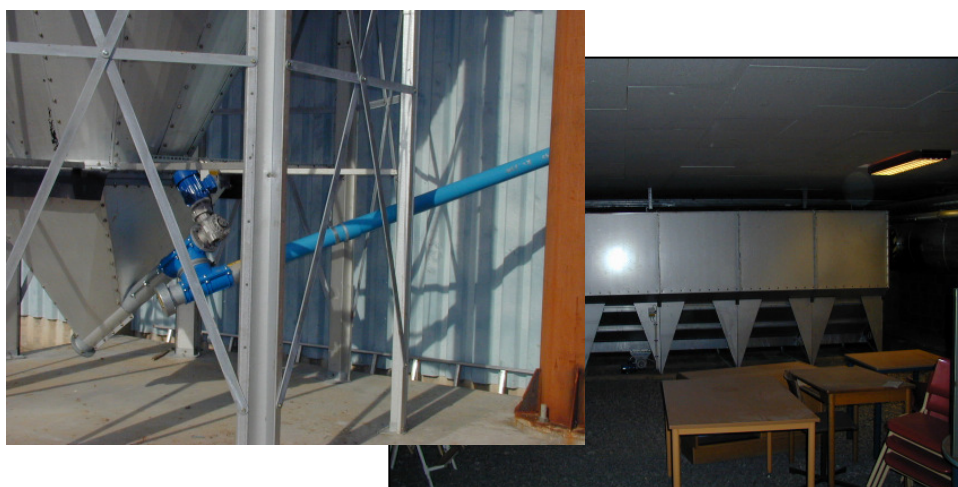
Rys. 10.7: Silos na pelety i przenośnik ślimakowy
