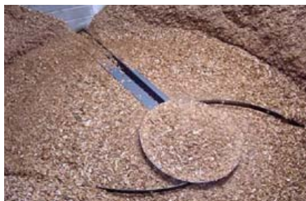
Rysunek 11. Wygarniacz i podajnik śrubowy w magazynie zrębków
