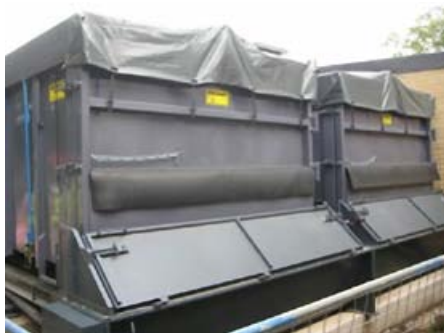
Rysunek 12. Kontenery na zrębki zintegrowane z podajnikiem ślimakowym
