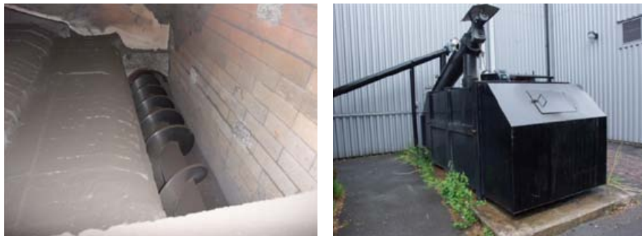
Rysunek 15. Automatyczny ekstraktor popiołu z wygarniaczem śrubowym z kotła oraz kontener na popiół
