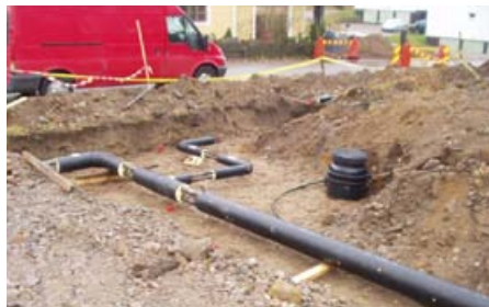
Rysunek 19. Układ sieci z rur podwójnych
