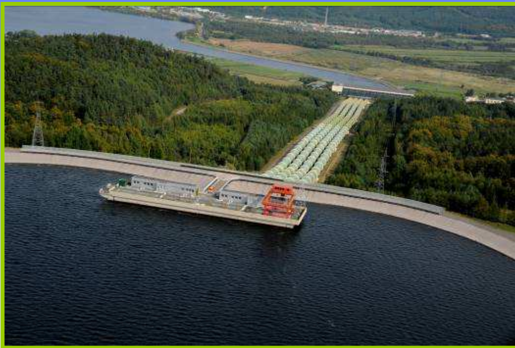
Elektrownia Wodna „Żarnowiec” działająca od 1983r. - moc 800 MW
