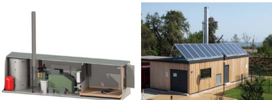
Rysunek 15. Kontenerowe kotłownie na biomasę
