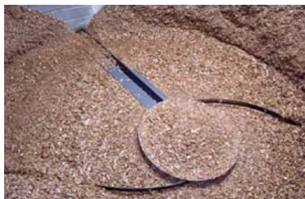
Rysunek 11. Wygarniacz i podajnik śrubowy w magazynie zrębków
