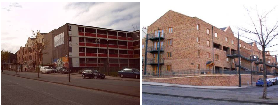
ulica Bridgefoot Street – przed i po termomodernizacji
