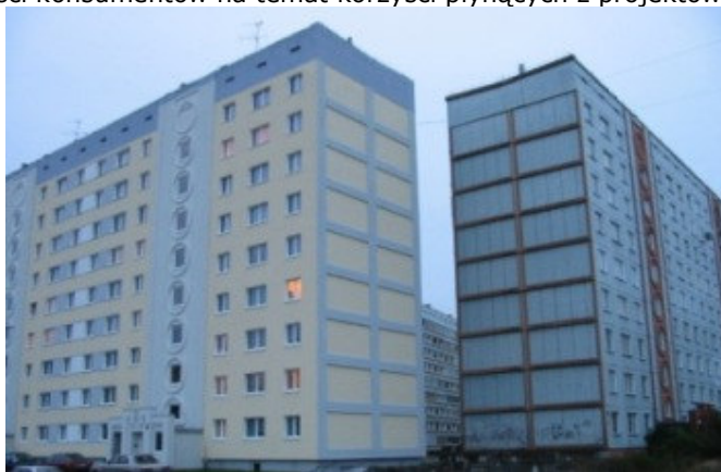
Zrealizowana inwestycja termo modernizacyjna w Rydze ©Instytut Energetyki Fizycznej – Łotewska Akademia Nauk
